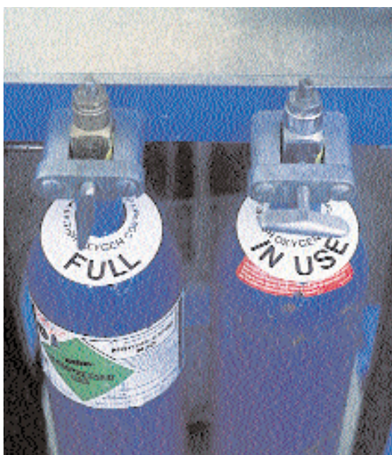
Fotografía 8. Botellas de óxido nitroso. Es conveniente identificar los envases vacíos, llenos y en uso.
